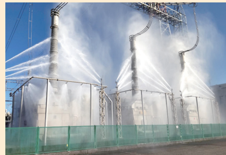
碍子洗浄・主変消火装置による主要変圧器への放水状況
