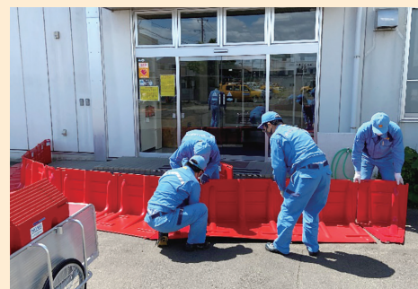
事務所玄関へのボックスウォール設置状況
